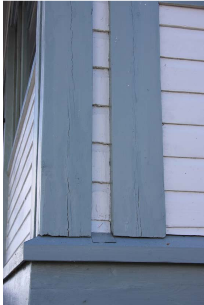
Större sprickor fylldes med trästickor och kittades med linoljekitt om brädet annars var användbart.
