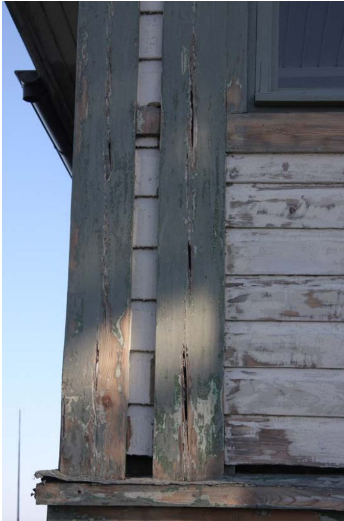
Större sprickor fylldes med trästickor och kittades med linoljekitt om brädet annars var användbart.
