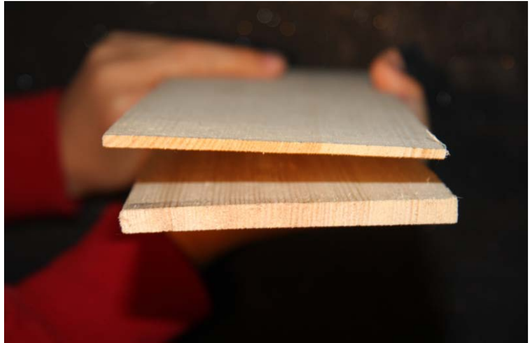
Bilder på nya spån. Spikhålet är ännu inte borrarat. Lägg märke till hur tätvuxna spånen är.
