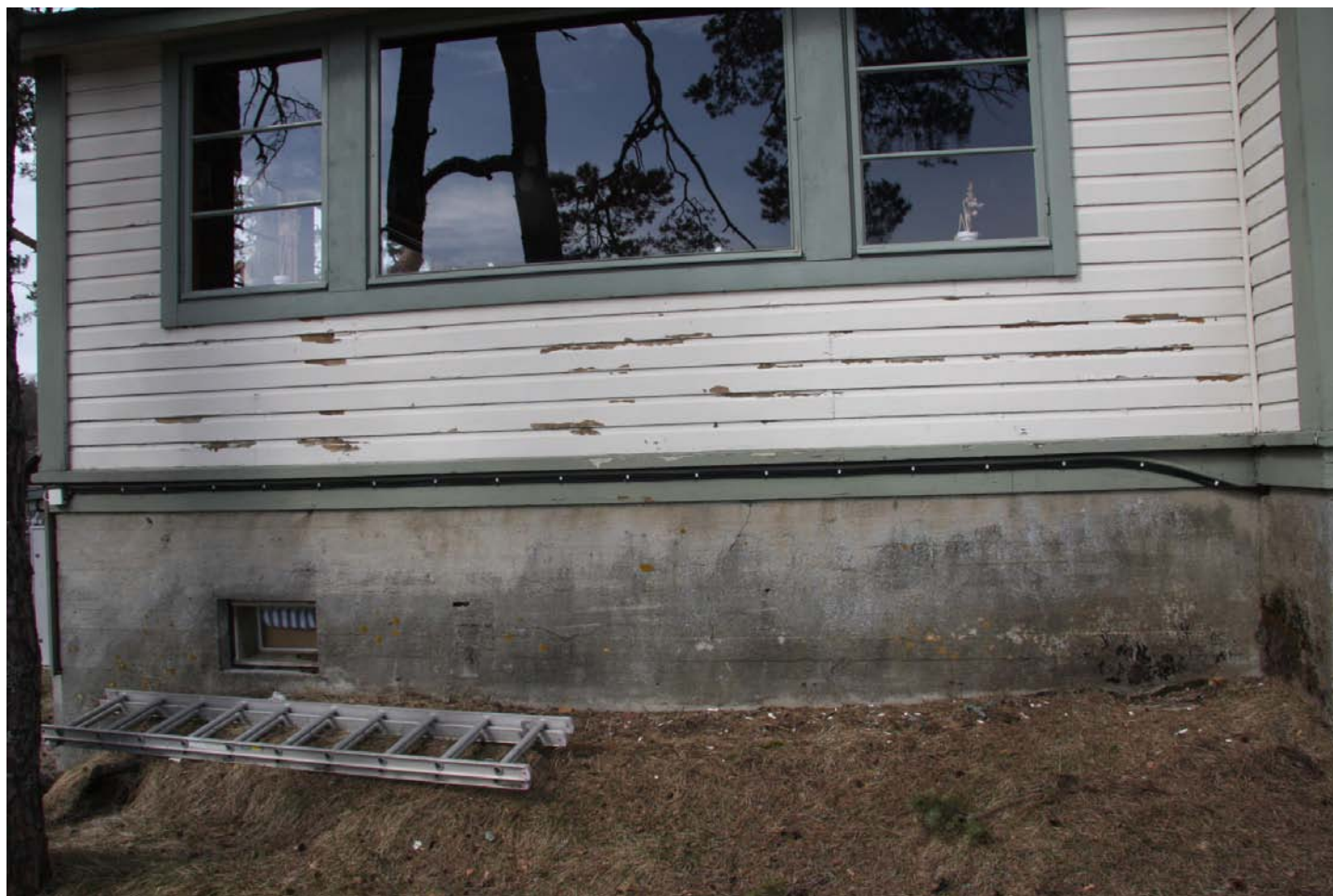
En vägg hade tidigare målats med latexfärg.
