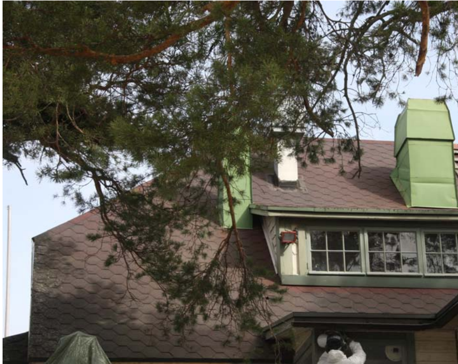
Skorstensplåtarna putsades och målades i samma färgton som fönstren. Takrännen och stuprör förnyades.
