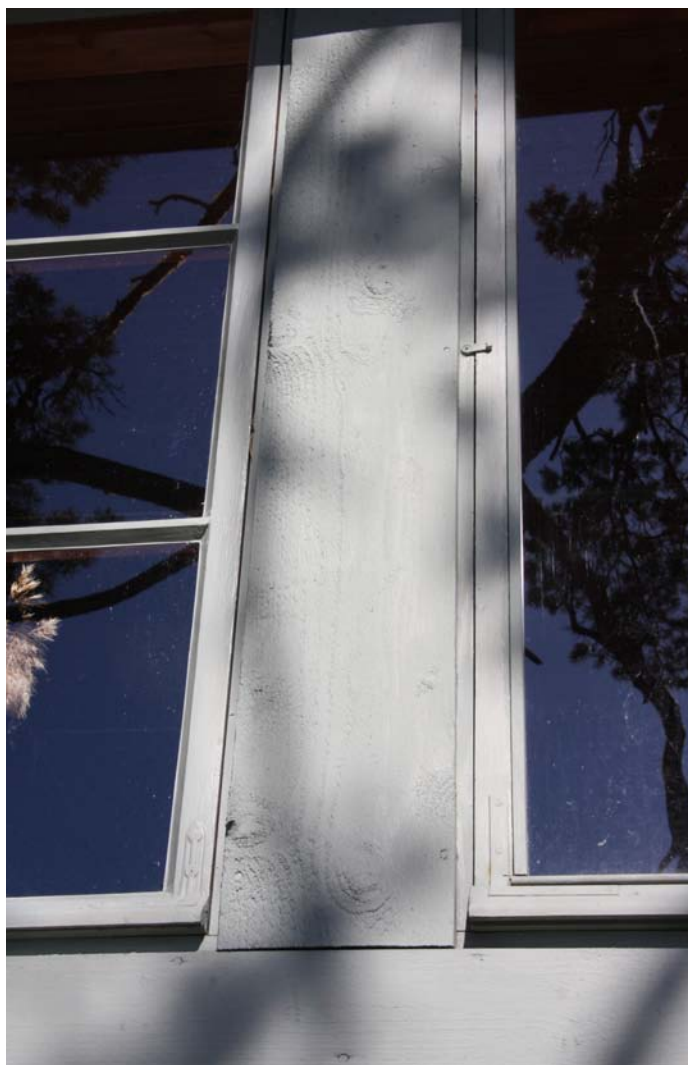
Alltför grovt sågat bräde byttes ut mot ett hyvlat bräde.
