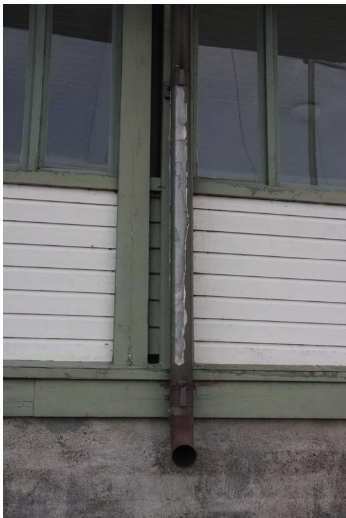
Stupröret på östra fasaden putsades och målades.
