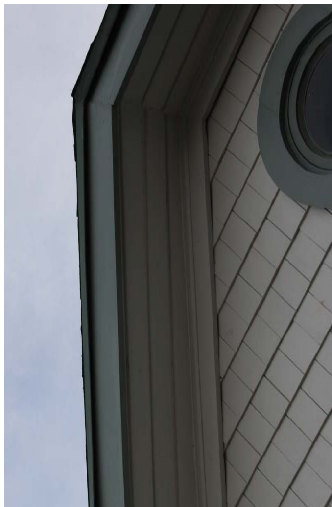
Plåten vid takkanten veks så att vattnet inte skulle rinna direkt på takkantsbrädet.
