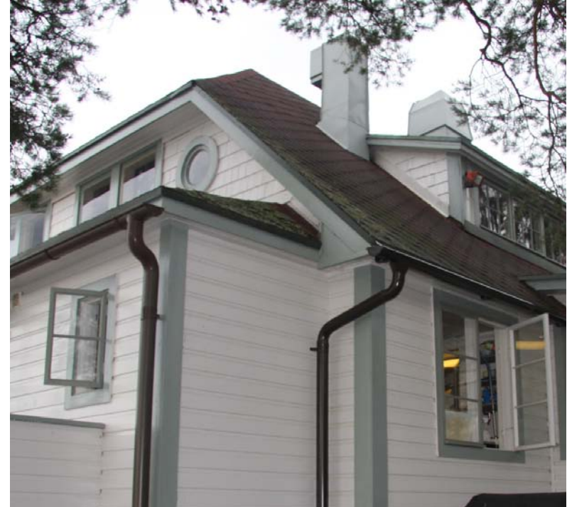
Skorstensplåtarna putsades och målades i samma färgton som fönstren. Takrännen och stuprör förnyades.
