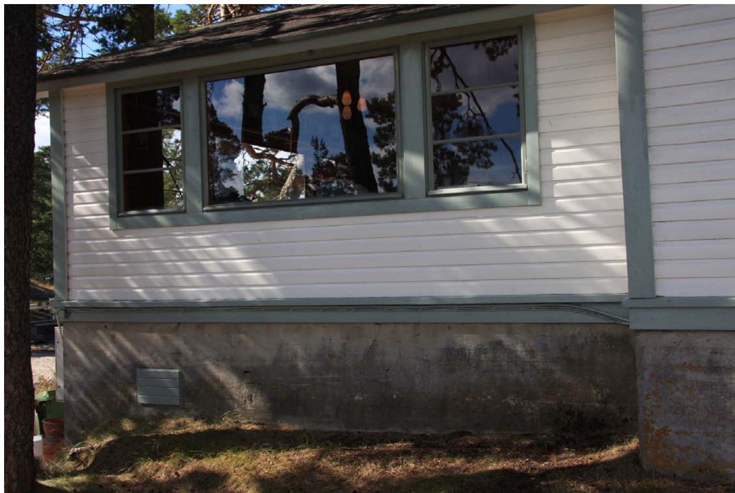
Elkablarna på södra fasaden målades med samma färg som väggarna.
