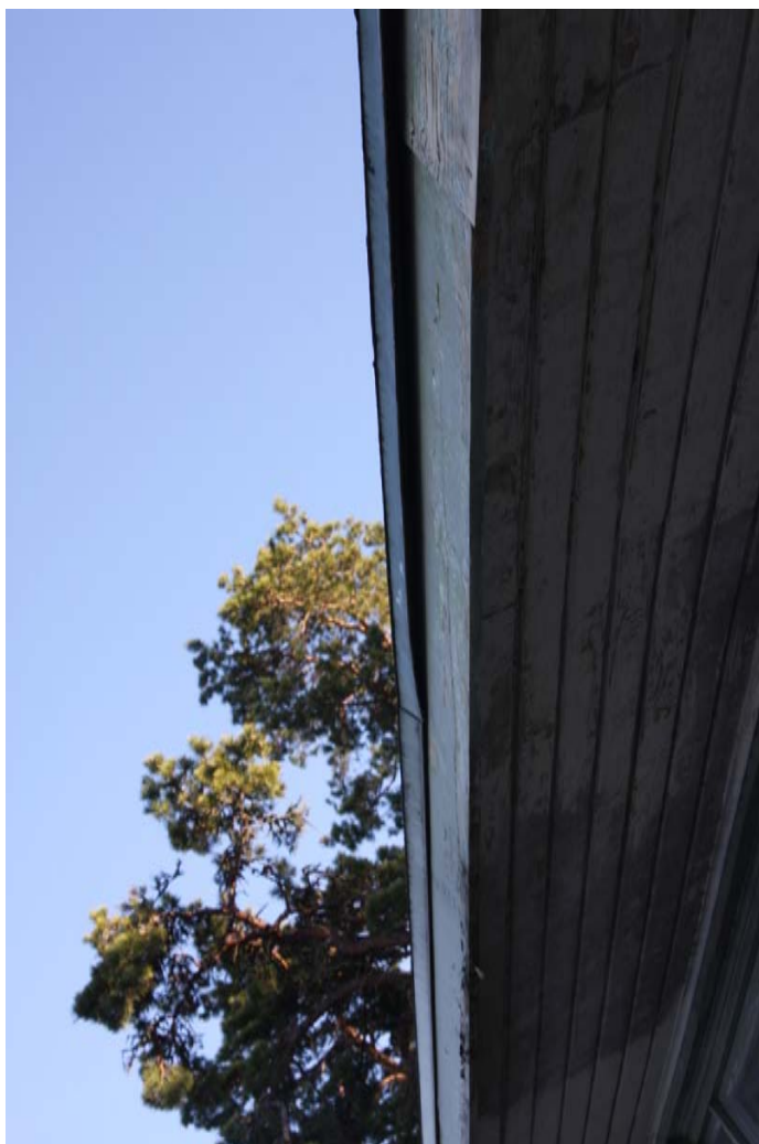
Plåten vid takkanten veks så att vattnet inte skulle rinna direkt på takkantsbrädet.
