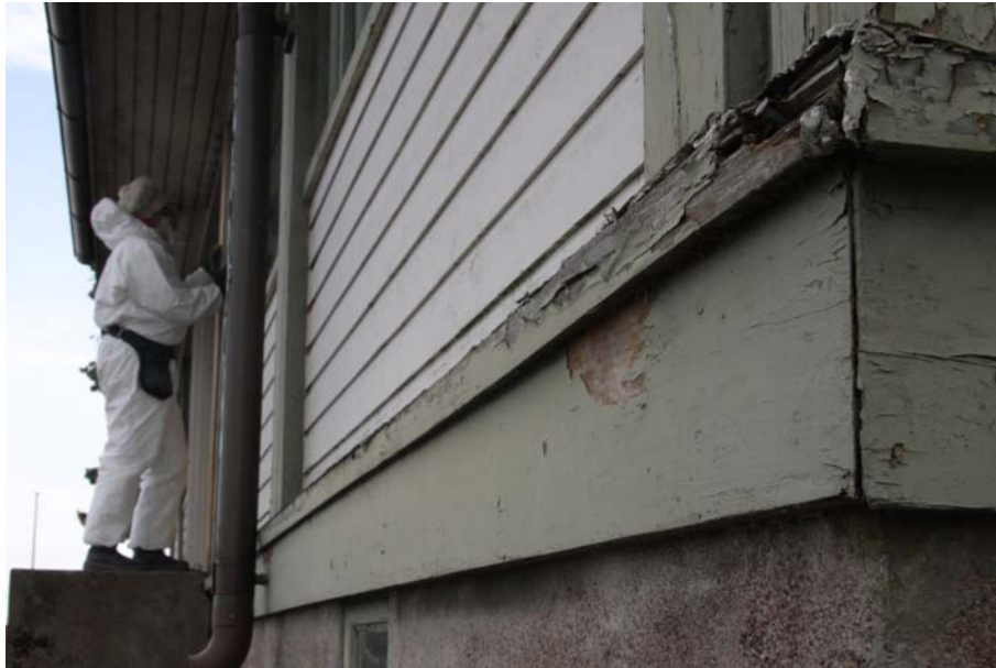
Dropplisten byttes ut mot en list av kärnvirke. Droppkanten gjordes bredare.
